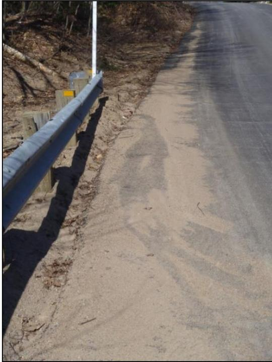
Figure 3 : Ruissellement de surface et transport de sédiments (abrasifs), route 351
