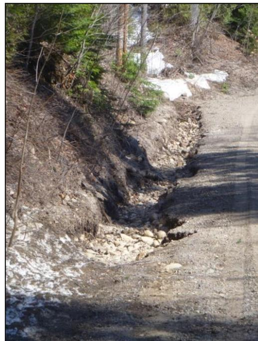
Figure 2 : Ruissellement de surface et écoulement préférentiel (site E13)
